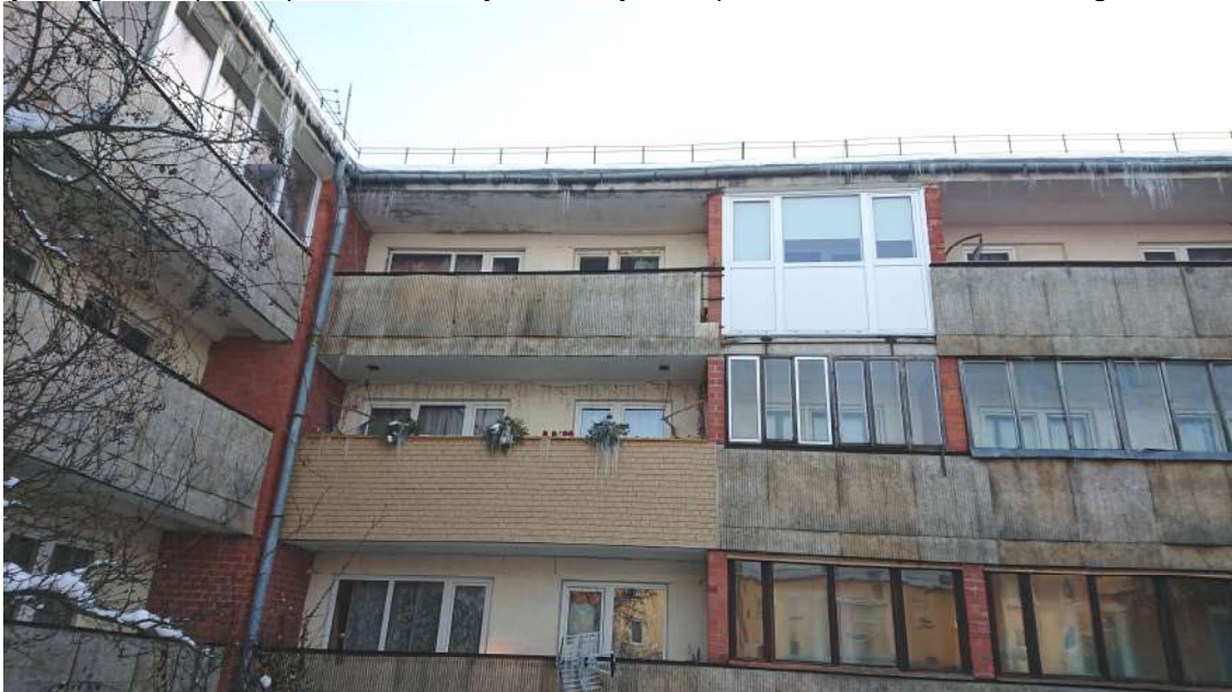
7.att. Pašreiz lodžiju apdarē ir dažādi risinājumi-esošās plātnes; PVC norobežojums, keramikas flīzes u.c.
