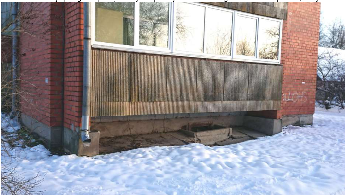
10.att. Pie pagraba logiem ir gaismas šahtas; pagraba logi nav nomainīti.
