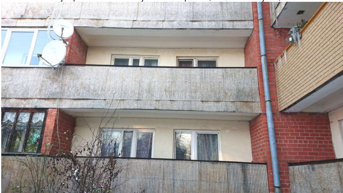
8.att. Pārsvārā lodžiju apdarē saglabātas esošās stiklaplasta plātnes, kas ir nolietojušās un jāmaina.
